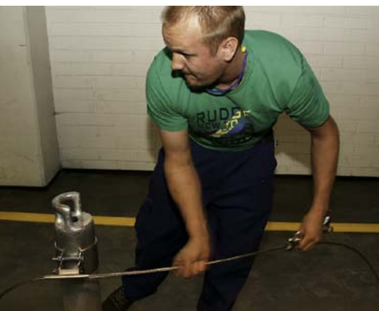
Turvatrossi paigaldamine kinnititele ja lõpp-pingutamine
